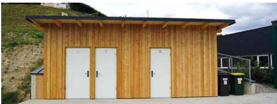
Ein neues öffentliches WC wurde neben dem ASK-Trainingsgelände errichtet. Um Vandalismus zu verhindern, ist das WC im Außenbereich mit einer Videoüberwachung ausgestattet
