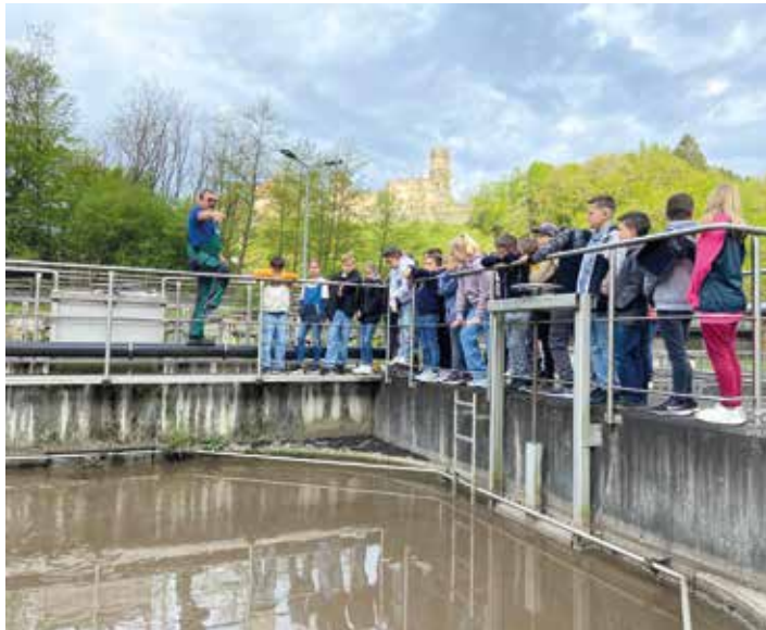
Die Kinder der VS Voitsberg lauschten interessiert den Erklärungen während der Führung durch die Kläranlage
